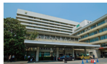
正面玄関 Main Entrance
