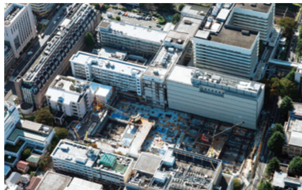
II期棟建設状況(2016年10月時点)
