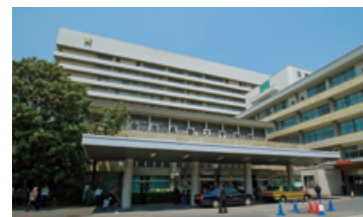
正面玄関 Main Entrance
