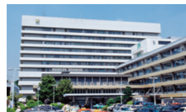
② 2号館 Building 2
