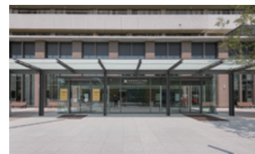
正面玄関 Main Entrance
